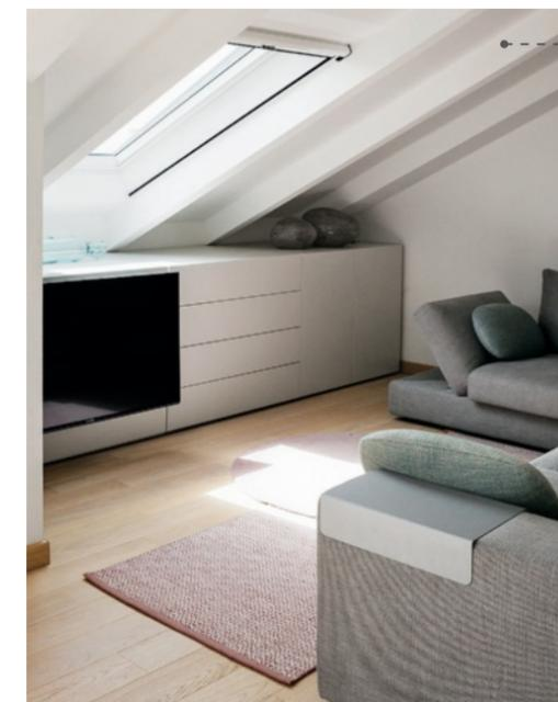
Le travi in legno verniciato bianco, che costituiscono la struttura portante della copertura, sono quelle originali della casa. Tra un elemento è l'altro è stato realizzato un tamponamento in cartongesso che ha anche una funzione isolante.
